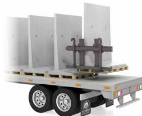
Fig 2.2 Lossning av T-stöd med gafflar
