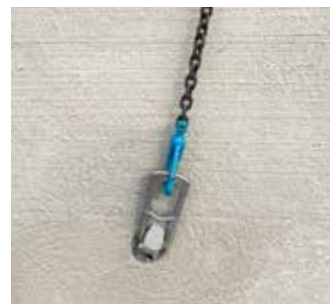
Fig 3.4 Våldsamma ryck vid resning av T-mur kan motverkas med dämpande material-
